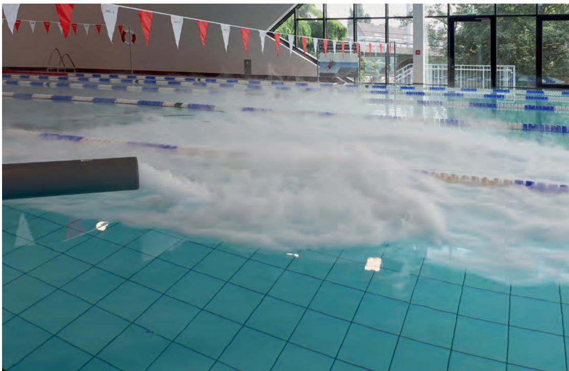
⑦ Luftschichtung im Betrieb
